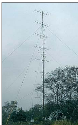
Bild 1: 8 x 5-Element-28- \Omega -Yagis bei 5P3WW auf der dänischen Insel Møn, JO64EX, EU-029
