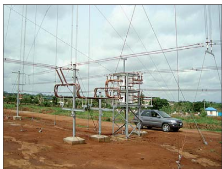
Phaseswitch: Mit dem Auto großen Phasenschalter lässt sich die Richtung der Vorhangantenne ändern
