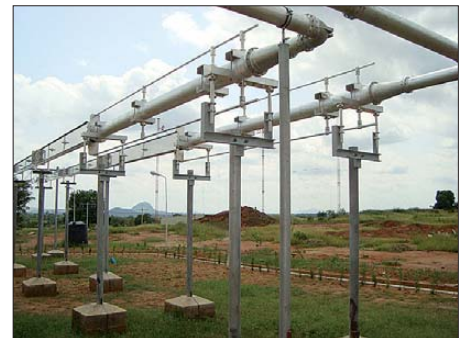
Balun von 50 \Omega auf 300 \Omega symmetrisch
