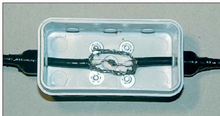
Bild 6: So werden die Aufstockkabel zusammenschaltet
